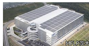
太陽光パネル
