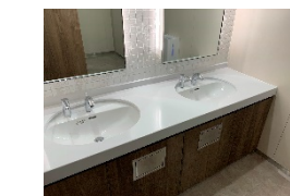
洗面器具等の更新 (Daiwa南青山ビル)
