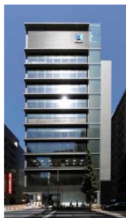
ヒューリック本社ビル
