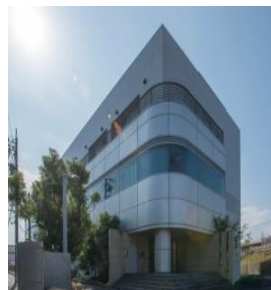
NW-04 ネットワークセンター 熱田ネットワークセンター
