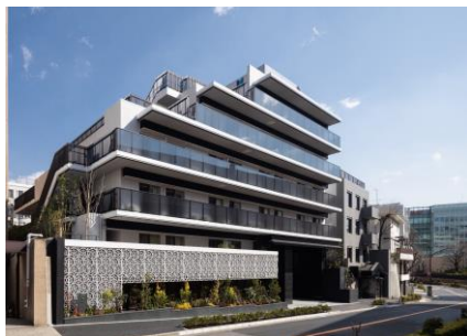
ホスピタルメント青山 (2022年3月竣工)
