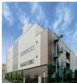
NW-01 ネットワークセンター 池袋ネットワークセンター
