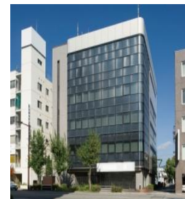
NW-05 ネットワークセンター 長野ネットワークセンター
