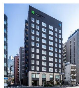
HT-03 ホテル ヒューリック築地三丁目ビル
