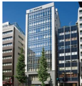
OF-07 オフィス 駅徒歩3分 ヒューリック神田橋ビル
