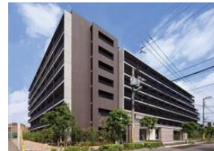
アリストージュ経堂 (2012年5月竣工)
