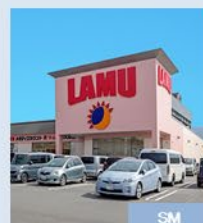
ラ・ムー東大阪店 （敷地）
