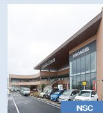
オアシスタウン 伊丹鴻池（敷地）
