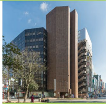
天神西通りビジネスセンター (底地)
