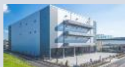
M-42 板橋物流センター
