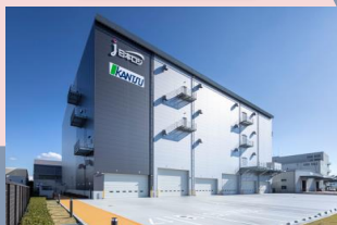
尼崎物流センター (2022年11月竣工済/取得予定)
