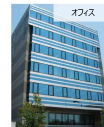
アルファ旭川ビル
