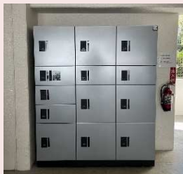
宅配BOX設置 (アルティザ東別院他)
