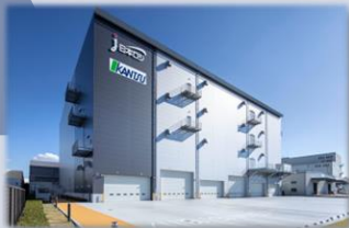
尼崎物流センター (2022年12月竣工/取得予定)
