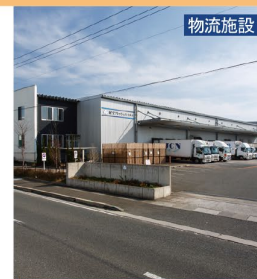
鳥栖ロジスティクスセンター
