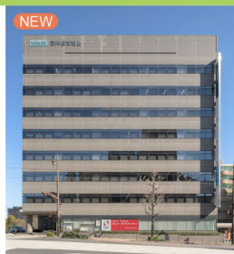
熊本イーストフロントビル
