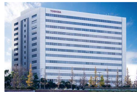
川崎東芝ビル（神奈川県川崎市）
