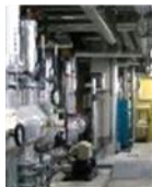
地中熱や温泉排湯を空調や給湯の熱源にするヒートポンプ設備
