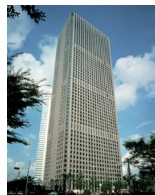
新宿センタービル
